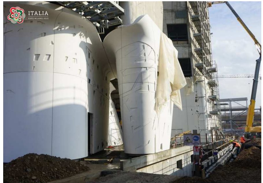
17/01/15: Rivestimento esterno angolo sud-ovest
